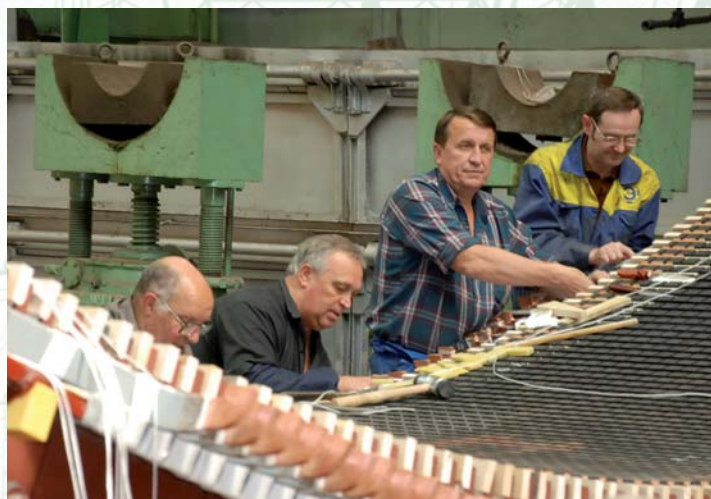
Так создавалось энергетическое оборудование для Сангтудинской ГЭС.
