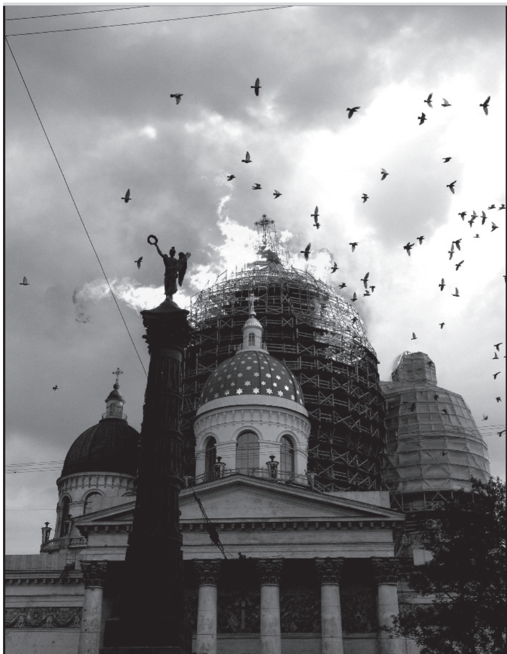
Рис. 2. Возгорание Троицкого собора в Санкт-Петербурге (фотография 25.08.2006 г.)
